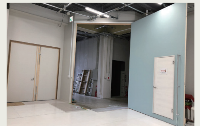
▲④斜めの扉を開けた状態
