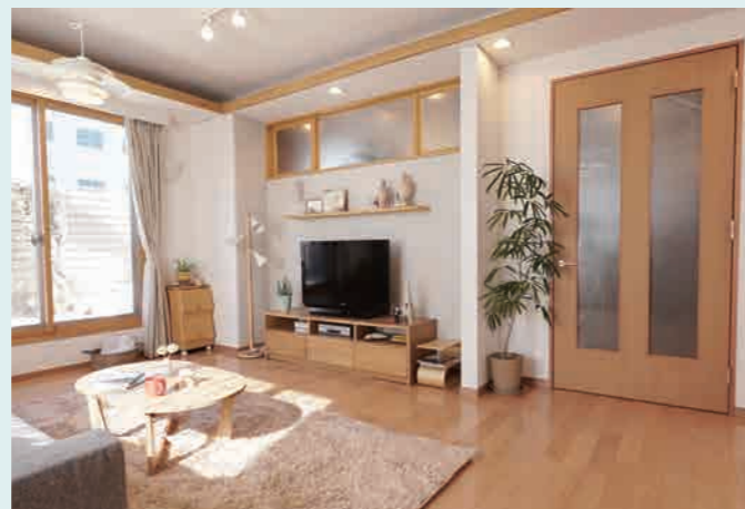
▲③仕切り壁はドアパネルと、高窓のパネルと柱で出来ています。
