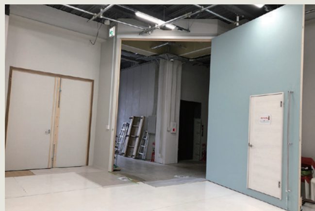
▲④斜めの扉を開けた状態
