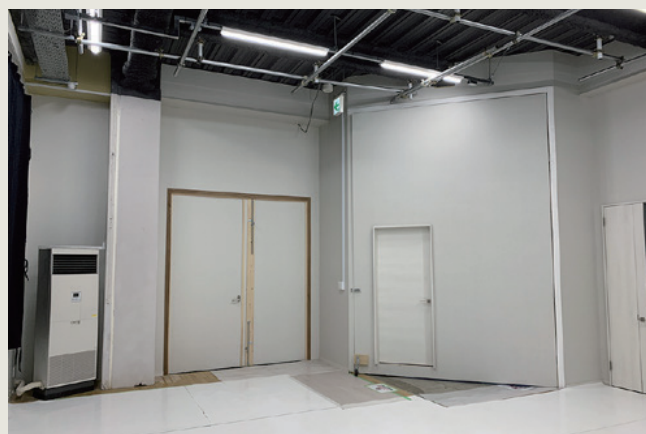
▲④斜めの扉は開くことができます。
