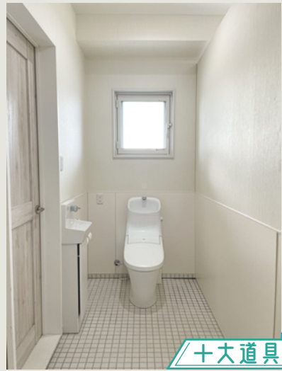
▲③壁を建てて、正面から見たトイレです。
